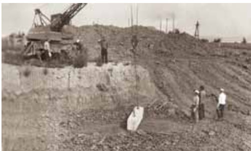
Закладка первого блока в фундамент диспансера
